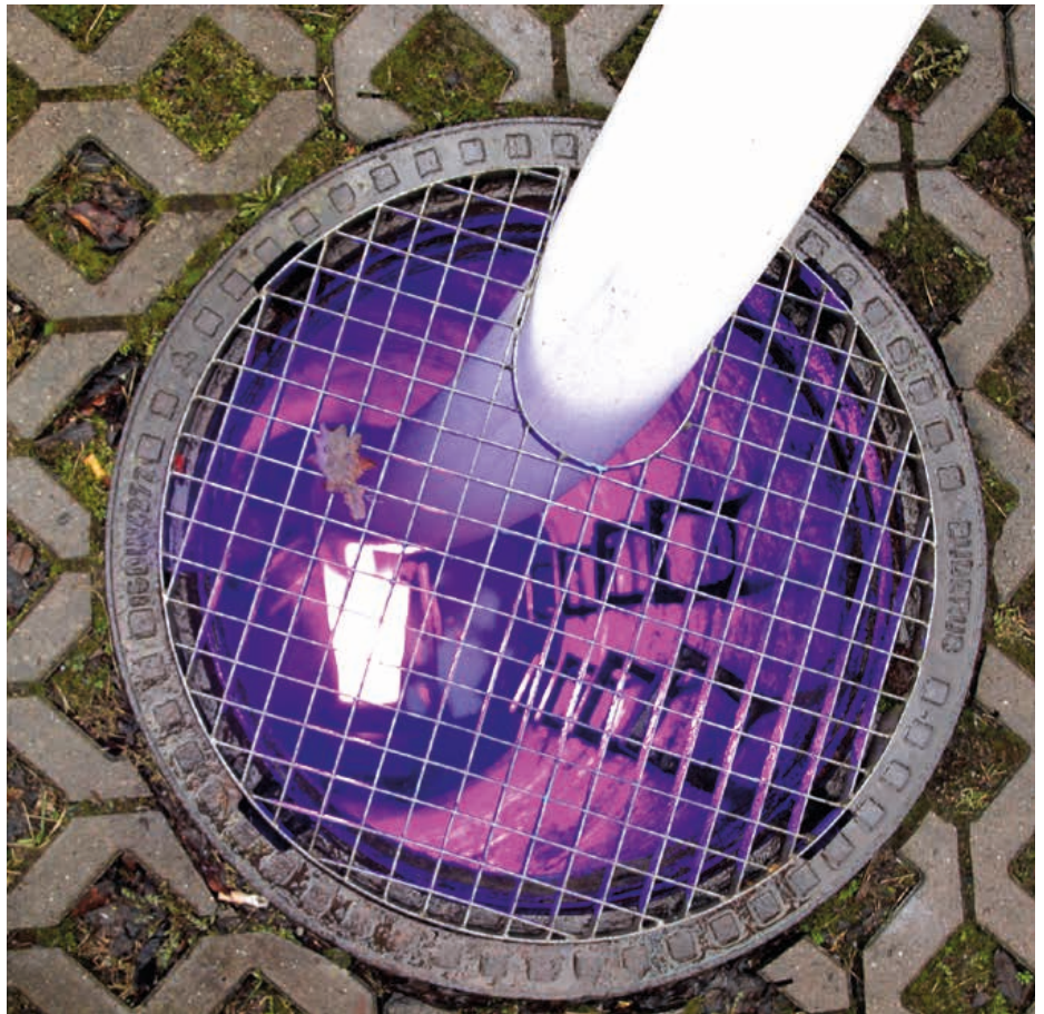
Aushärtung eines Schlauchliners mit der Bluelight-LED-Technik | Fotos: Sanierungstechnik Dommel
